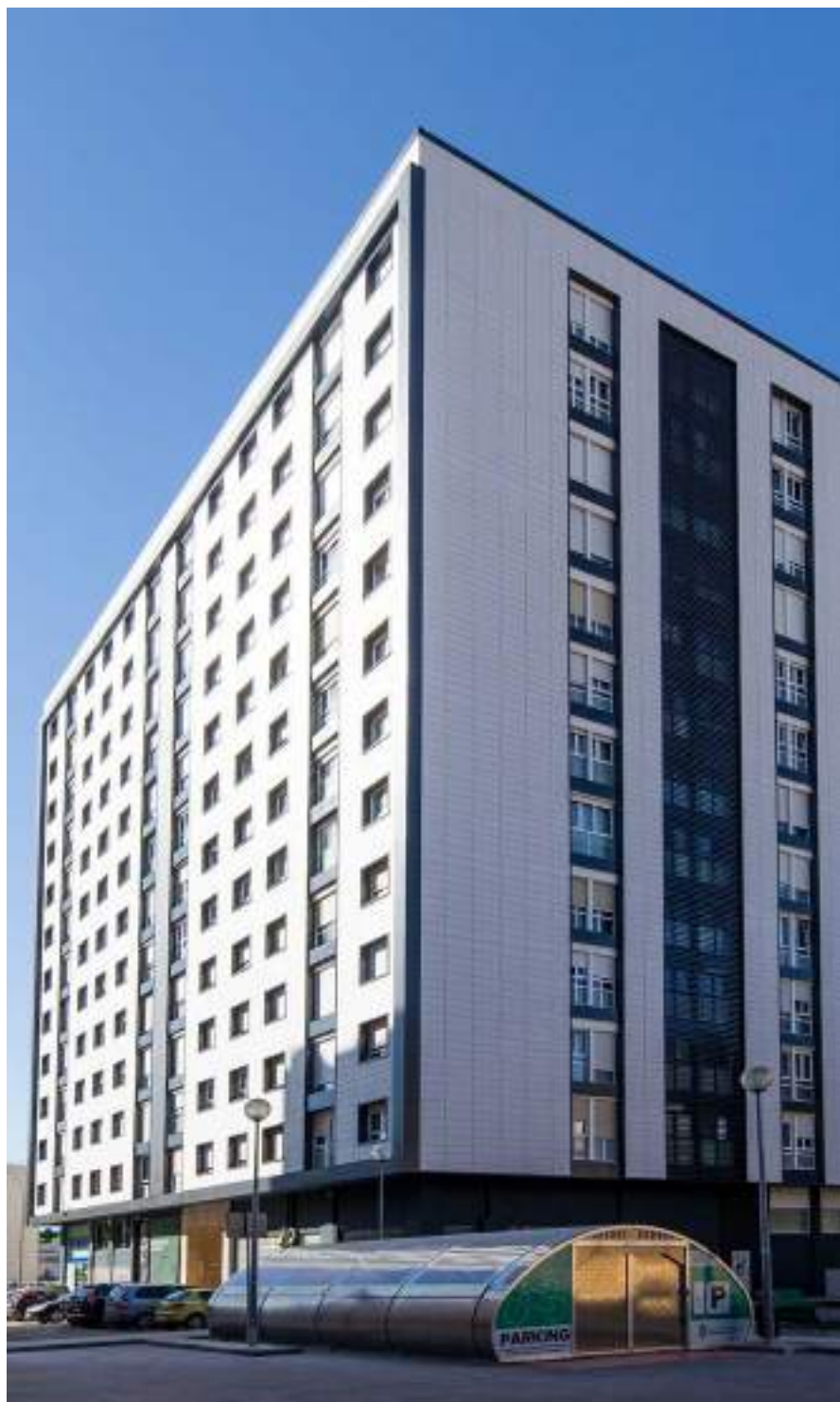
Proyecto de rehabilitación Torre Irrintzi, Pamplona.
