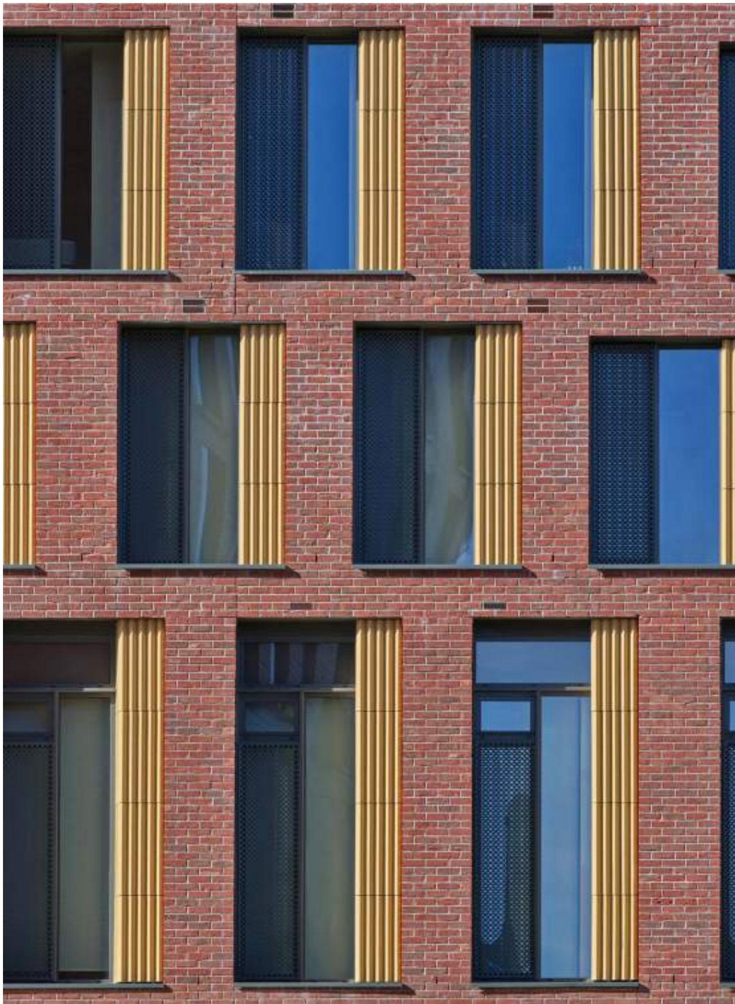
44 Merrion Street, Leeds Reino Unido. Detalle de Multifuncional Z5.
