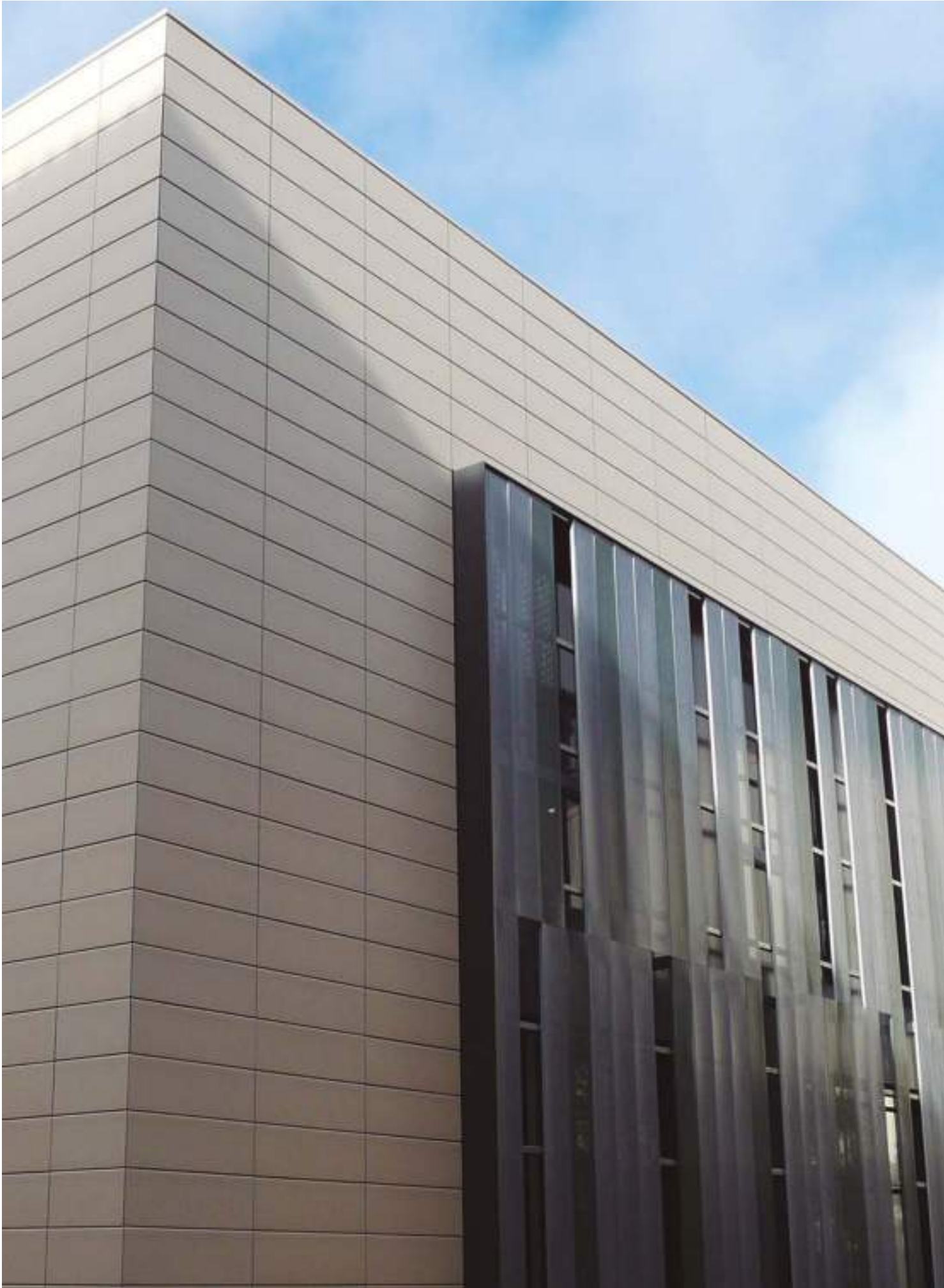
Edificio residencial Solsona, España.
