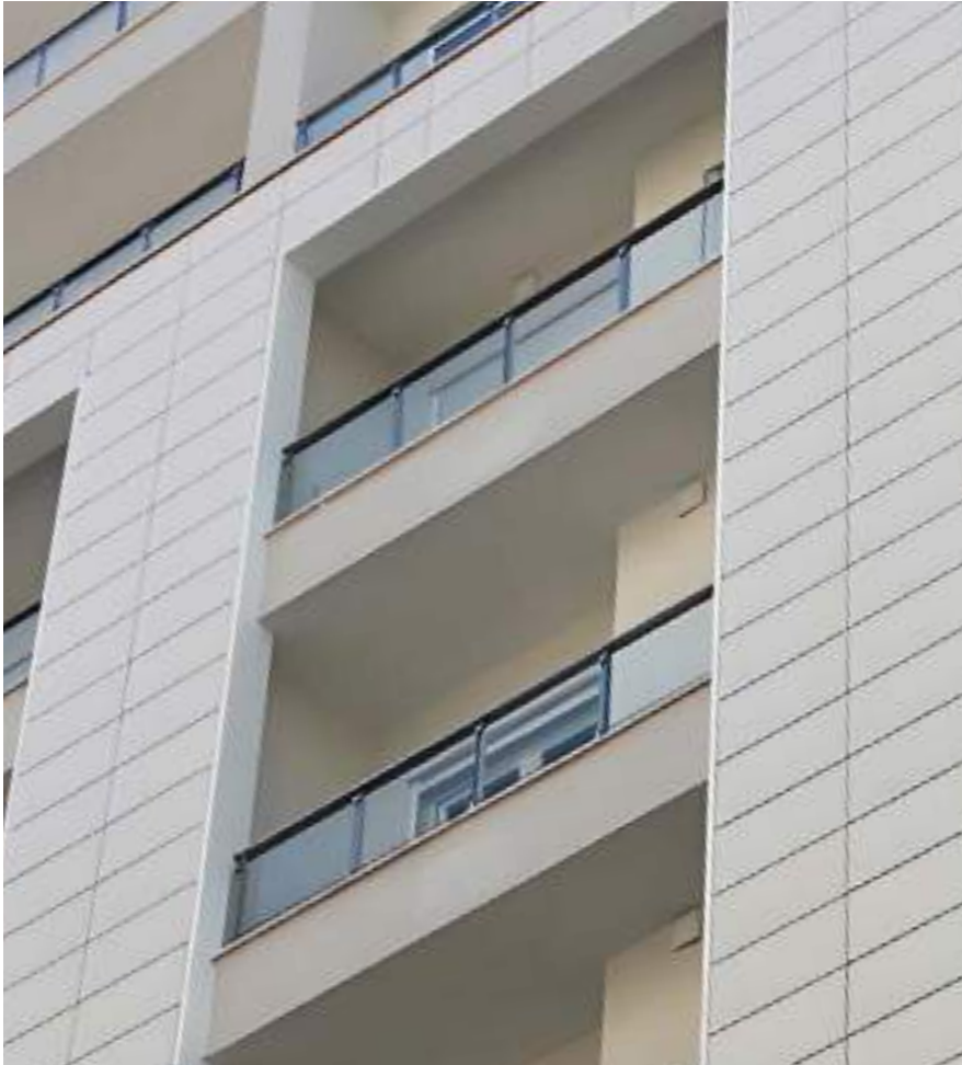
EDIFICIO DITMAR FREDI Tirana, Albania
